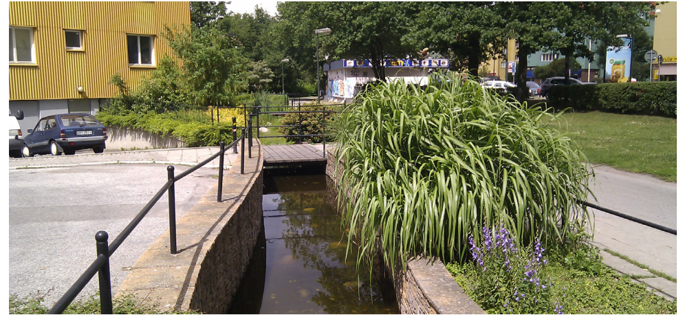
70. attēls. Lonngatan ielas lietusūdeņu koridora galā ir izveidots dīķis ar strūklaku. Caur kupolveida restēm ūdens ietek sūknī un tiek pārsūknēts uz kanāla sākumu (ap 60 m augštecē), lai nodrošinātu ūdens cirkulāciju. Otrā kupolveida restes nodrošina pārplūdi uz lietusūdeņu kolektoru. Avots: autoru arhīvs
