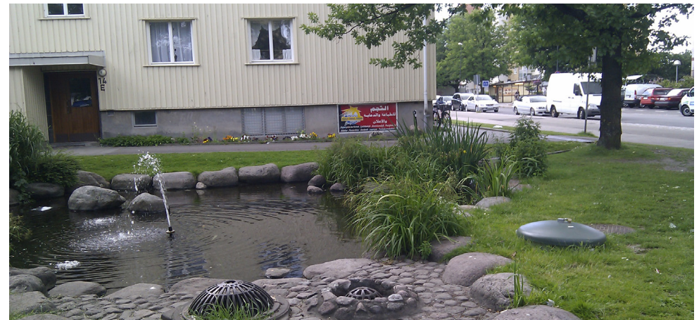
70. attēls. Lonngatan ielas lietusūdeņu koridora galā ir izveidots dīķis ar strūklaku. Caur kupolveida restēm ūdens ietek sūknī un tiek pārsūknēts uz kanāla sākumu (ap 60 m augštecē), lai nodrošinātu ūdens cirkulāciju. Otrā kupolveida restes nodrošina pārplūdi uz lietusūdeņu kolektoru. Avots: autoru arhīvs
