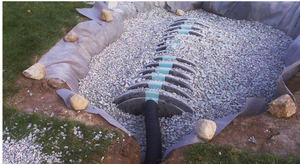
38. attēls. Infiltrācijas tuneļu izbūve
