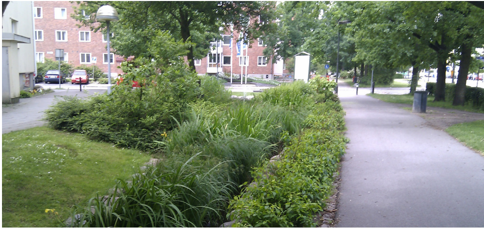
67. attēls. Bioievalka, kas savienojas ar kanālu. Avots: autoru arhīvs
