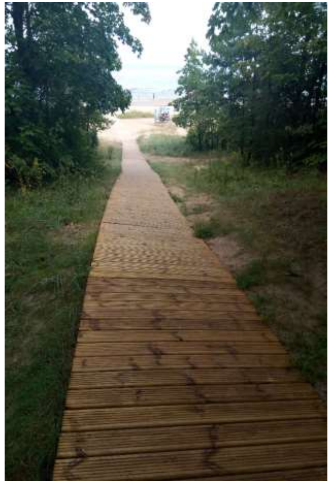
Slokas ielas izeja: 62 koka laipu posmi 1.5mx 2m un 2 koka posmi 1.5m x0.5m(uzeja/noeja)
