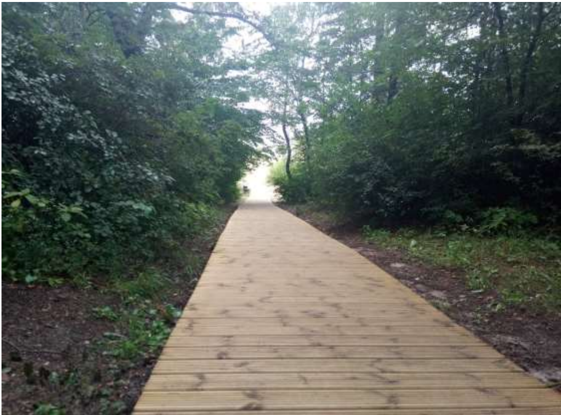
Mālpils ielas izeja: 74 koka laipu posmi 1.5mx 2m un 1 koka posms 1.5m x 0.5 m (noeja)
