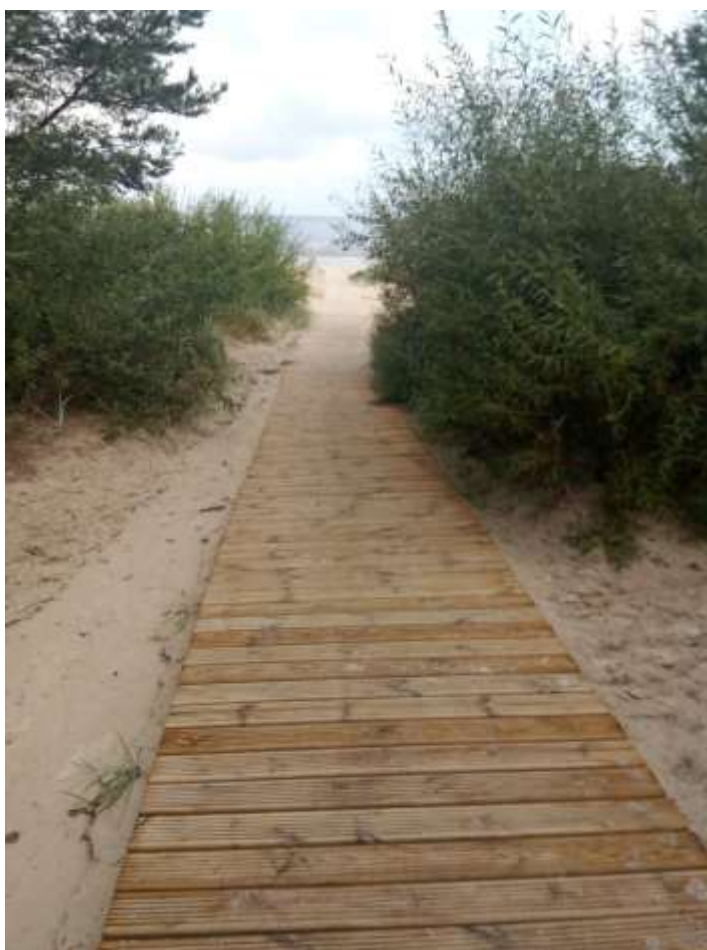
Peldu ielas izeja: 32 koka laipu posmi 1.5mx 2m un 2 koka posmi 1.5m x 0.5 m(uzeja/noeja)
