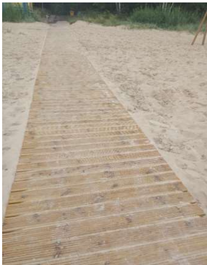
Drustu ielas izeja: 24 koka laipu posmi 1.5mx 2m un 1 laipu posmi 1.5mx0.5m(uzeja/noeja)
