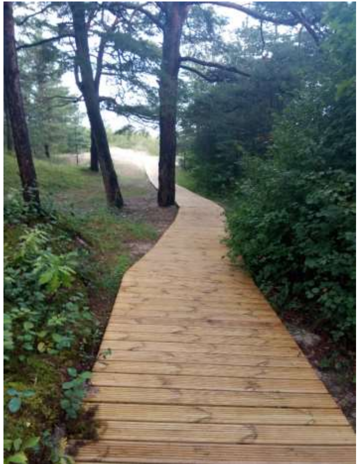
Gundegas ielas izeja: 90 koka laipu posmi 1.5mx 2m un 2 koka posmi 1.5m x0.5m(uzeja/noeja)
