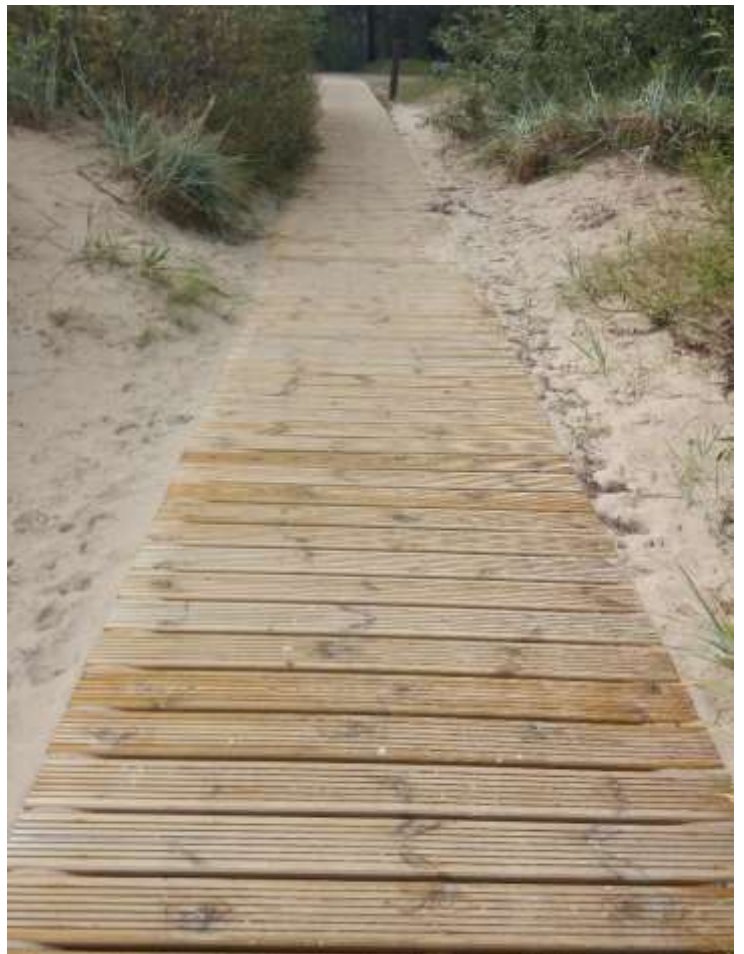
Upes ielas izeja: 36 koka laipu posmi 1.5mx 2m un 2 koka posmi 1.5m x 0.5 m (uzeja/noeja)
